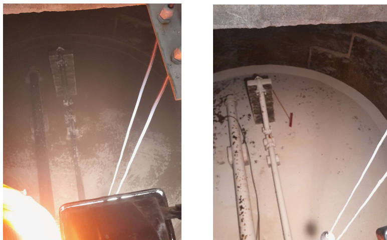
Nettoyage cuve du réservoir Jovets 200 m³
